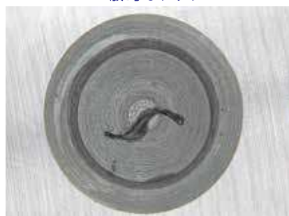
ドリルなどの切りくずが残る
